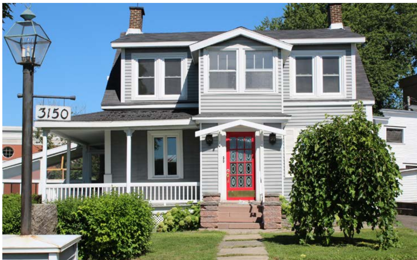
L'apparition d'une affiche devant le 3150 Girouard Ouest à Saint-Hyacinthe, portant la mention avis de démolition, a fait réagir.
