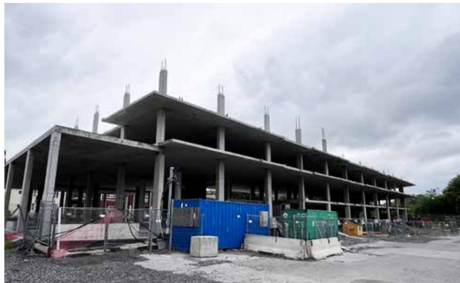
Le projet de Corev Immobilier (anciennement Groupe Sélection) devrait reprendre d'ici la fin de l'année 2024. Il est situé derrière le Centre des arts Juliette-Lassonde.
